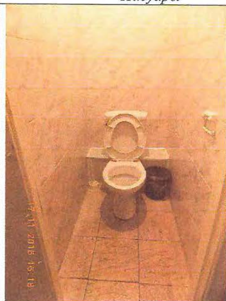
Фото № 161 Кабина санузла
