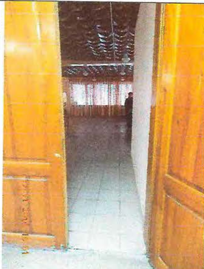
Фото № 121 Дверной порог
