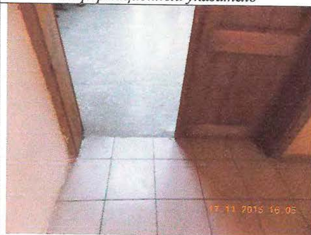
Фото № 137 Дверной порог
