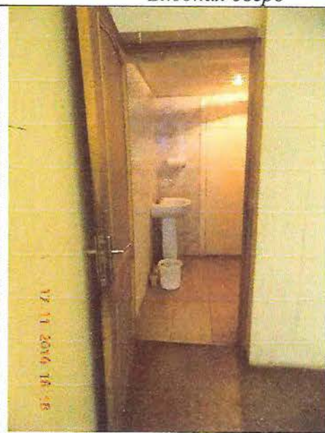
Фото № 157 Дверной порог
