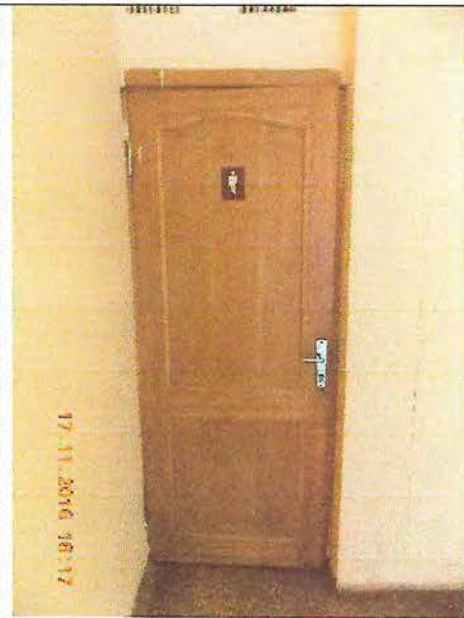
Фото № 155 Входная дверь
