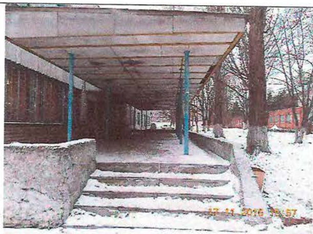
Фото № 109 Пути эвакуации из столовой санатория профилактория
