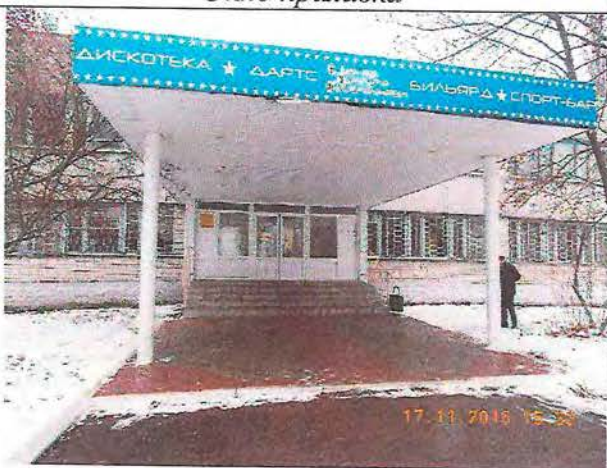
Фото № 107 Пути движения являются путями эвакуации
