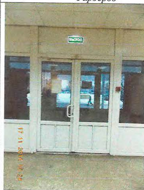
Фото № 106 Пути эвакуации из вестибюля
