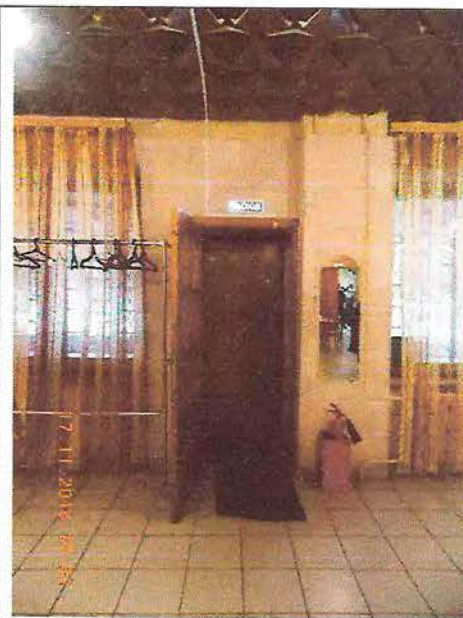
Фото № 124 Тамбур отсутствует
