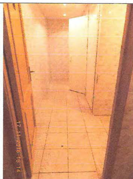
Фото № 145 Входная дверь
