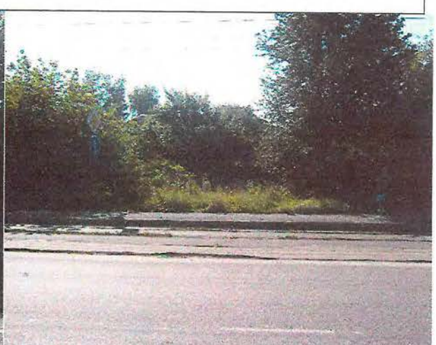
Фото № 181 Отсутствует остановочный комплекс.
