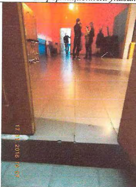
Фото № 138 Дверной порог на входе в центр досуга на 2-м этаже
